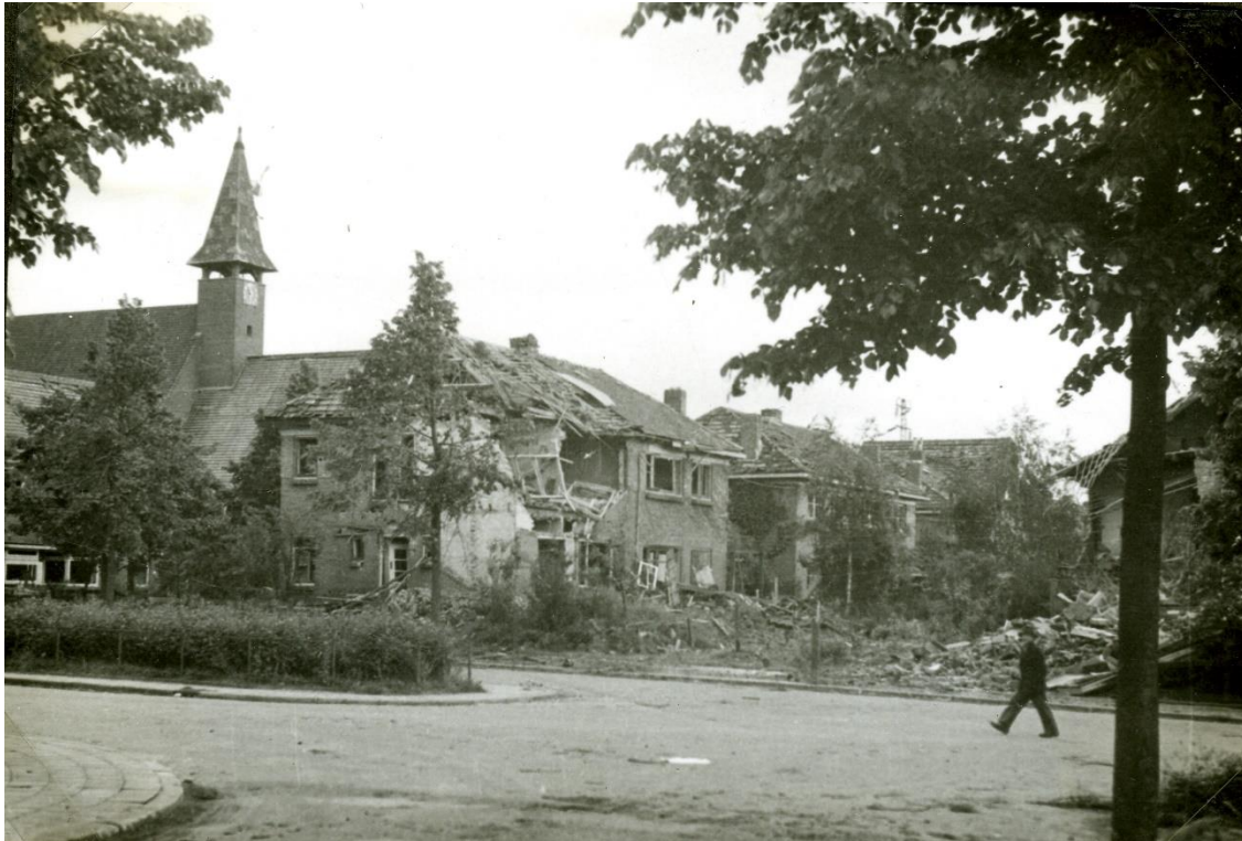
Oorlogsschade in de Potgieterstraat, gezien vanaf de Vondellaan, mei 1945. Op de voorgrond de beschadigde panden Vondellaan 36 en 38. Gelders Archief 1523_148-0318
